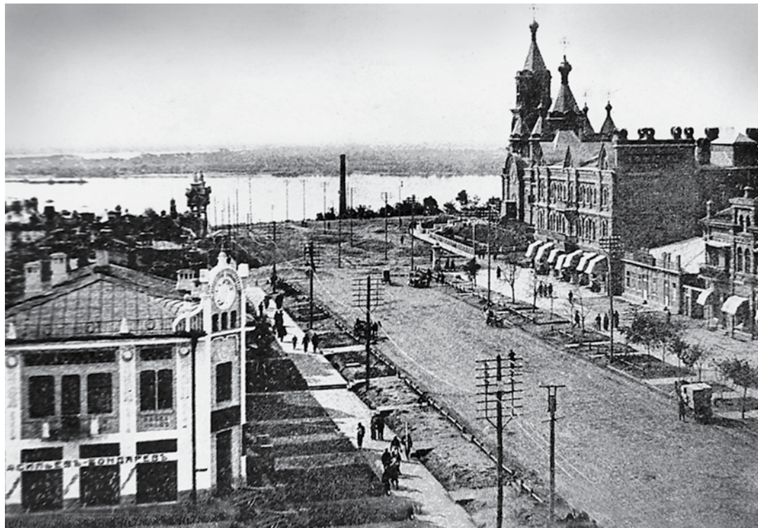
Вдоль улицы Муравьева-Амурского была проложена одна из первых линий водопровода
